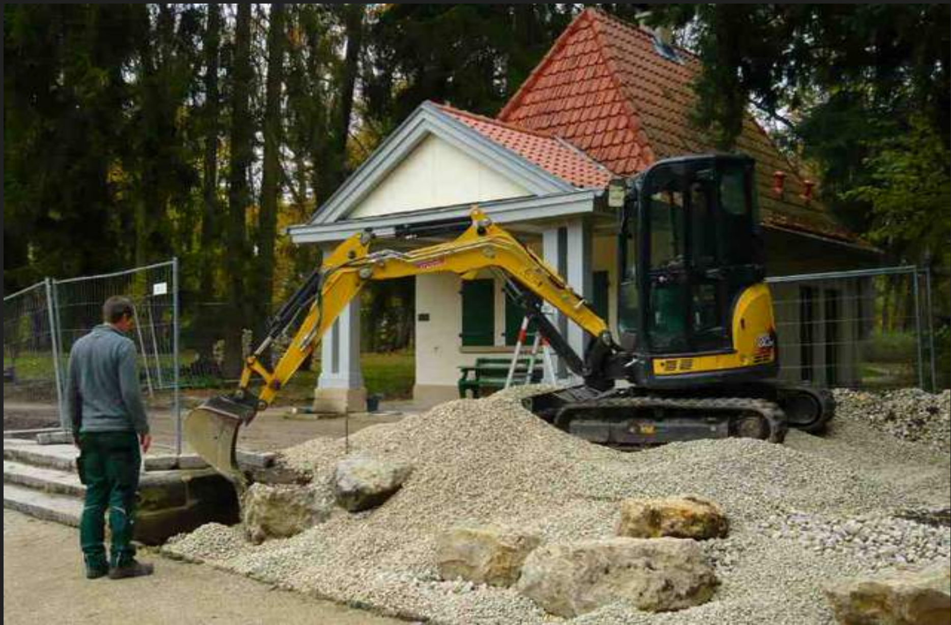
Bau der Jurabeetes, 06.11.2017
