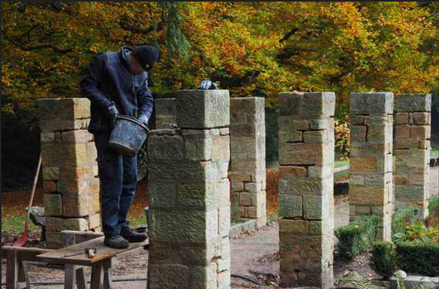
Sanierung der Pergolenpfeiler, 28.10.2016
