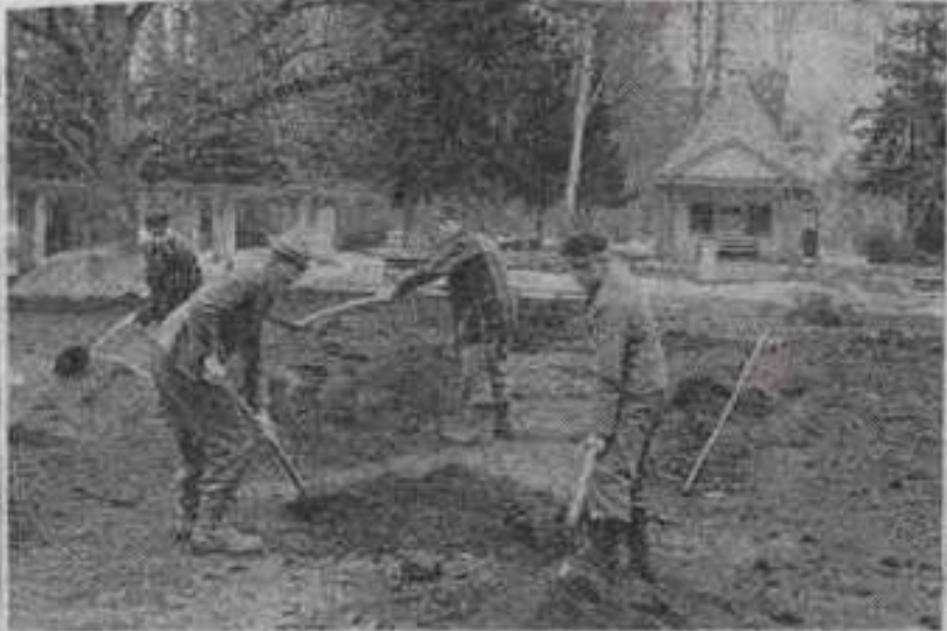
Im Botanischen Garten wird fleißig gearbeitet, um ihm ein völlig neues Bild zu geben. Die Reihtraubenden Hecken sind verschwunden, eine großzügige Anlage entsteht. Foto: F1-Bauer
