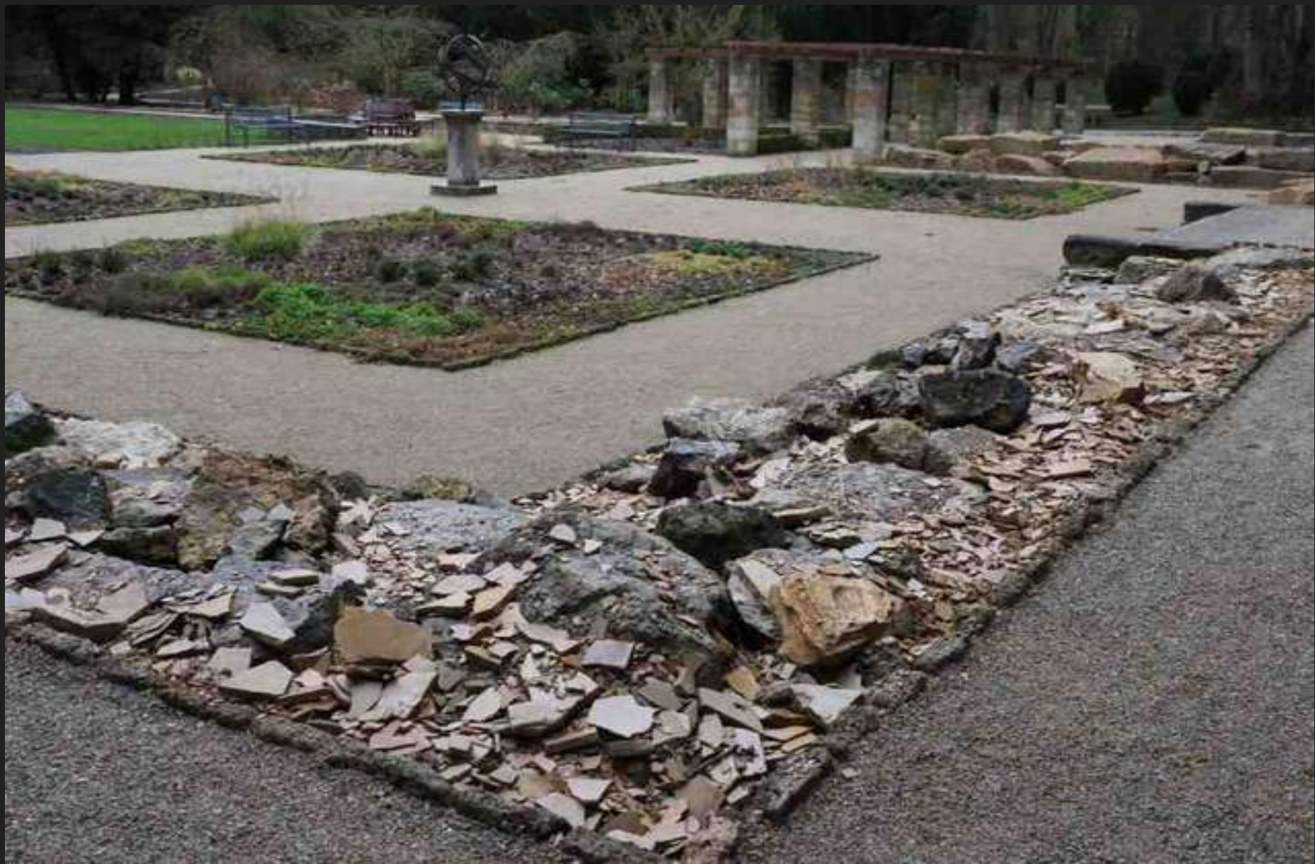
Provisorischer Einbau der Jurasteine, 16.01.2018
