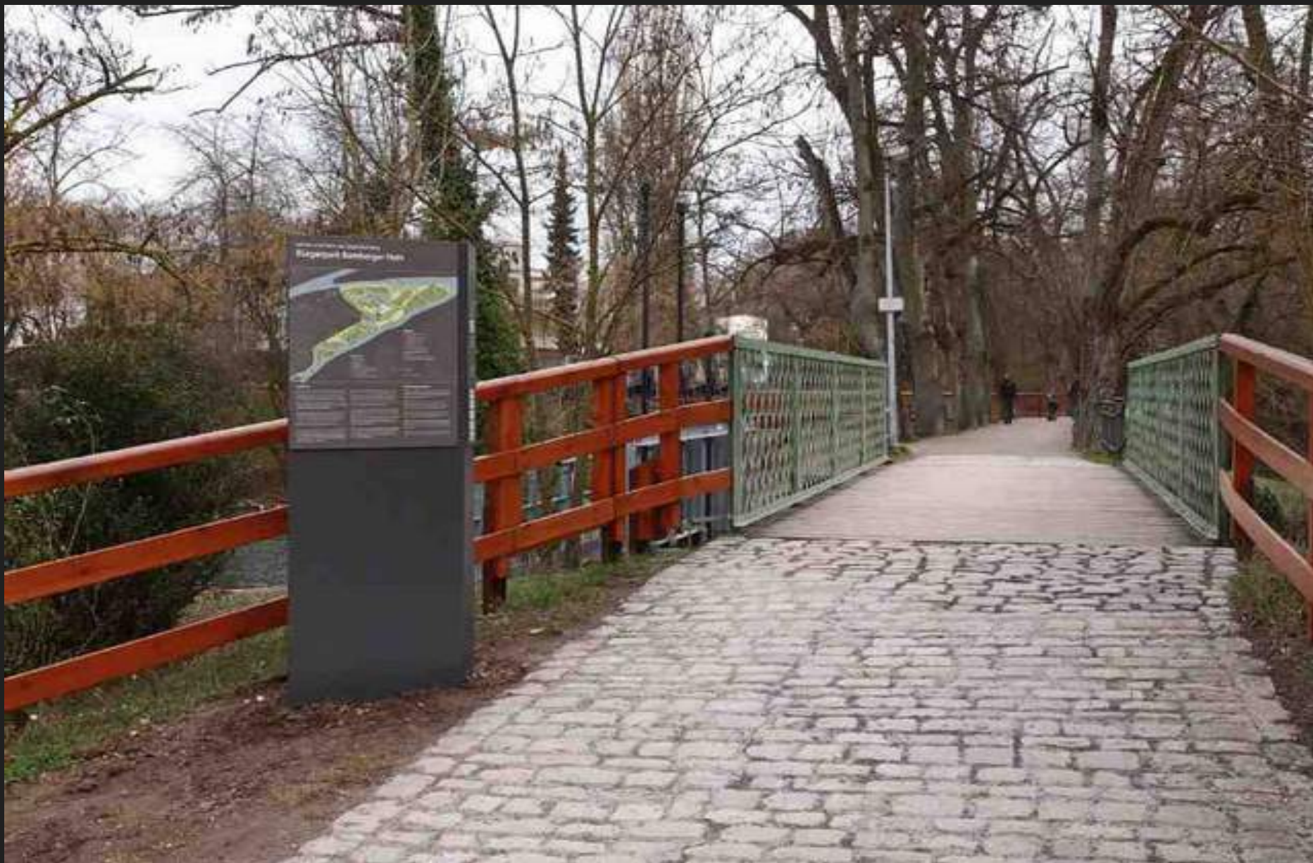
Neue Eingangsstele an der Stengelallee, 06.03.2019
