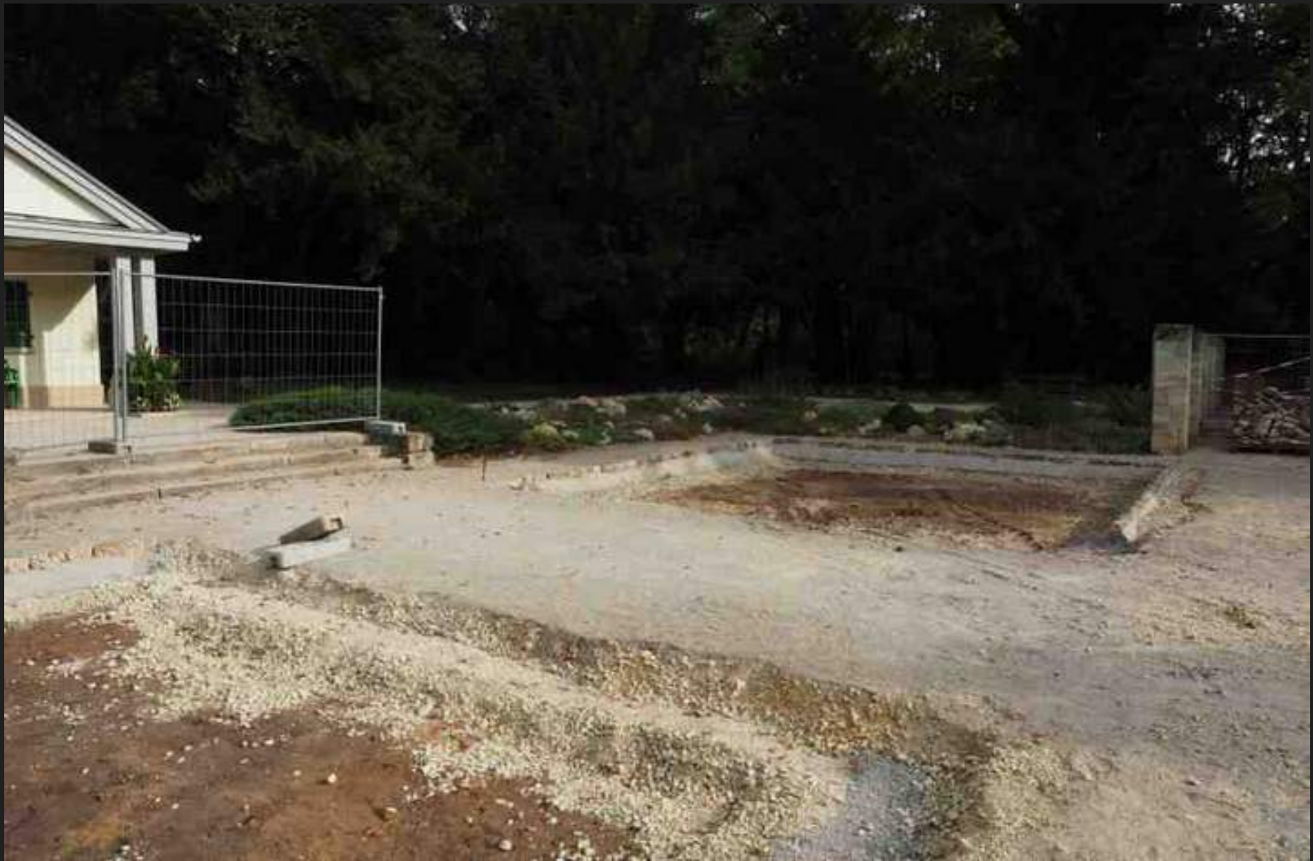
Neuanlage der Wegeflächen und Beeteinfassungen des Gartenparterres vor den Metznerhäuschen, 17.10.2016
