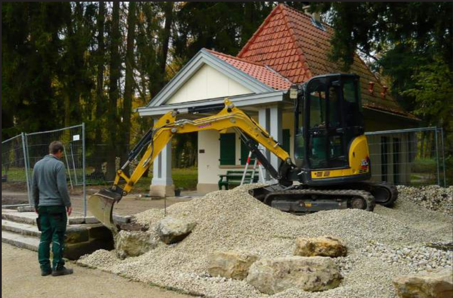
Bau der Jurabeetes, 06.11.2017
