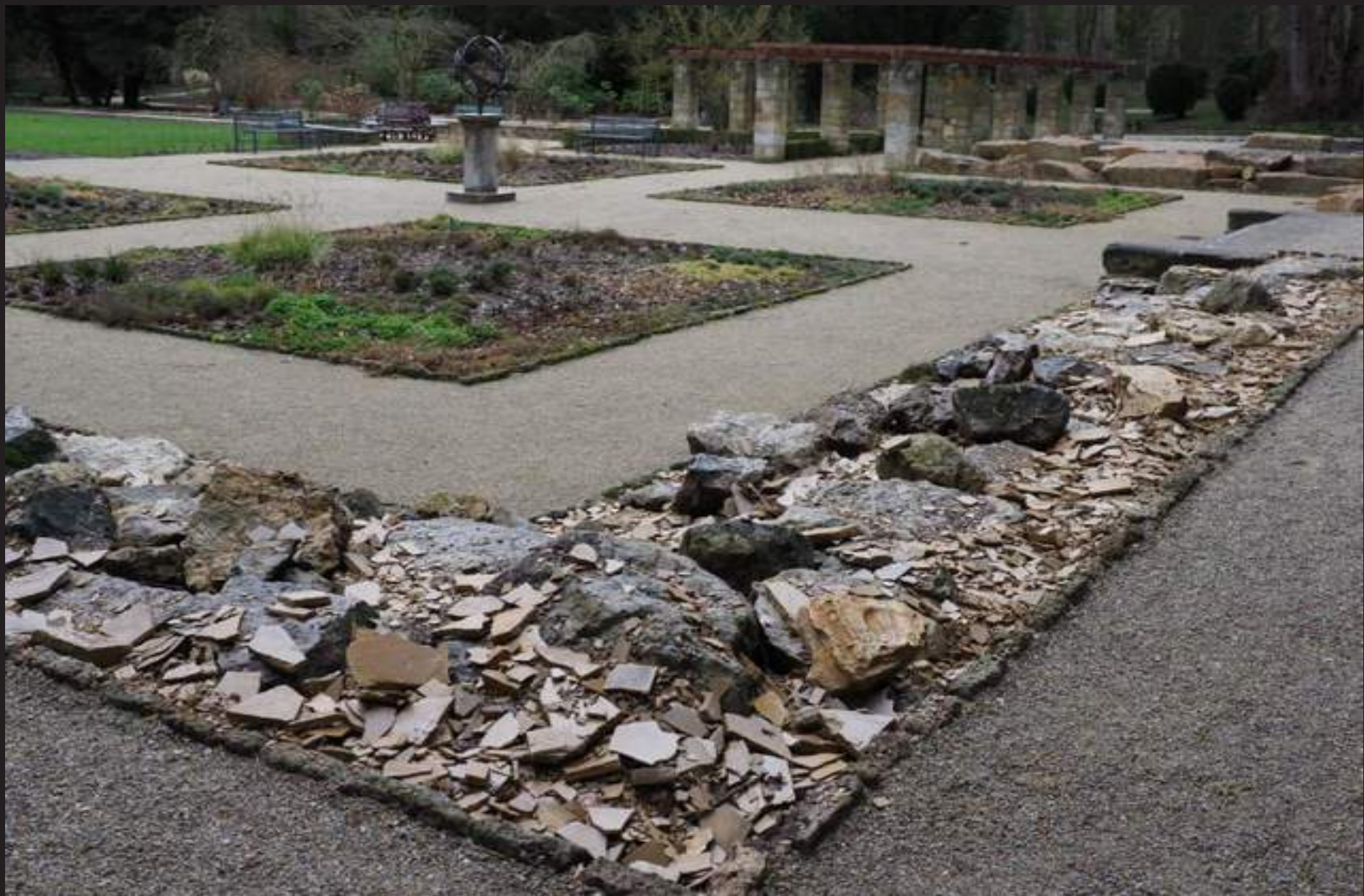
Provisorischer Einbau der Jurasteine, 16.01.2018
