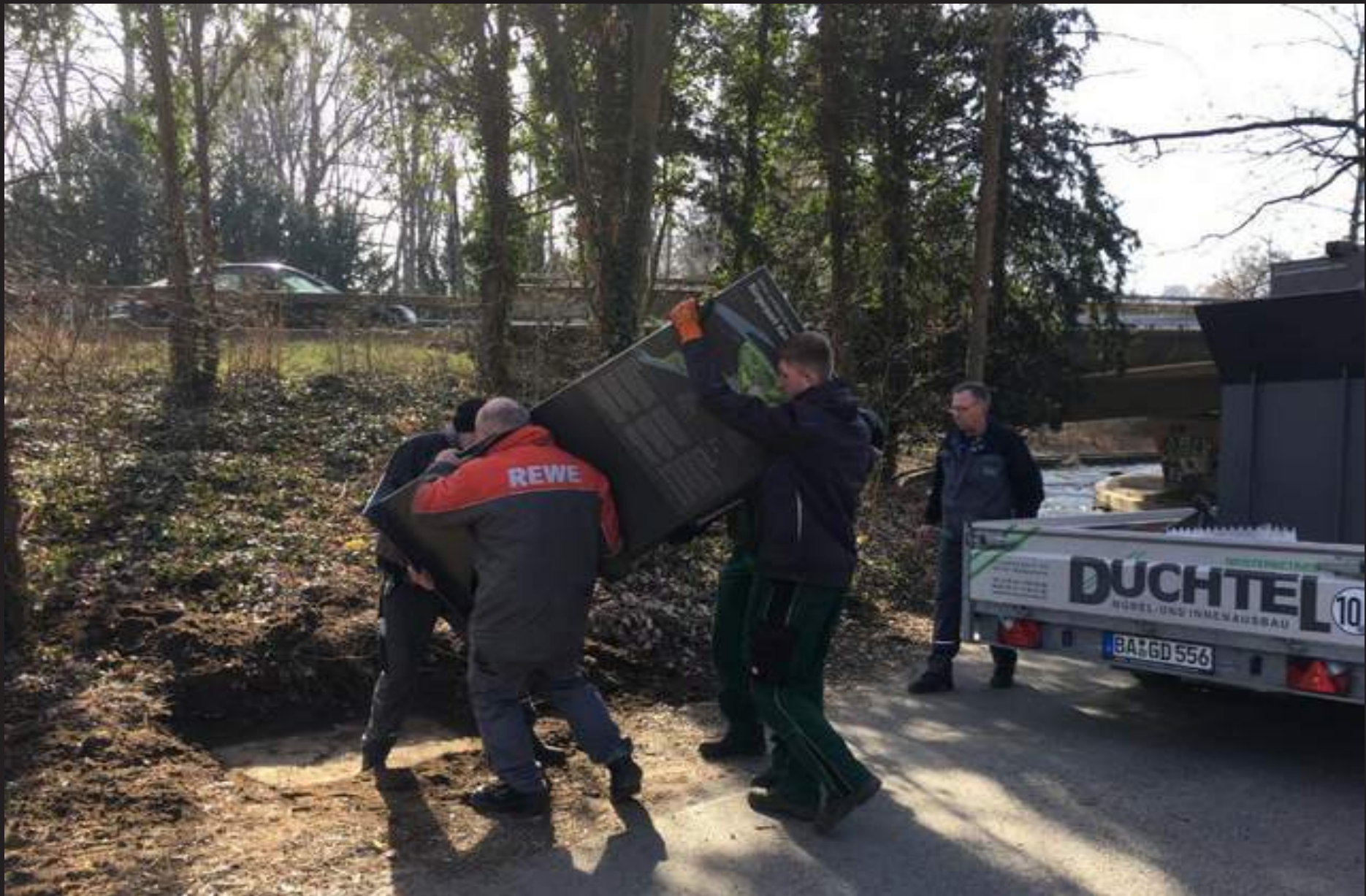
Aufbau der neuen Infostelen an den Haineingängen, 25.02.2019
