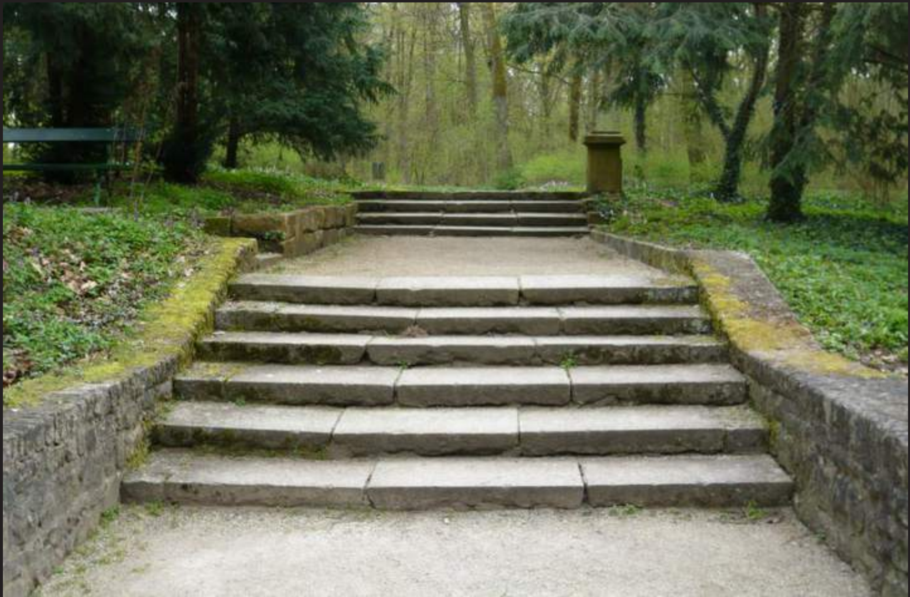
Treppe am westlichen Ende der Hauptwegeachse des Botanischen Gartens, 11.04.2016
