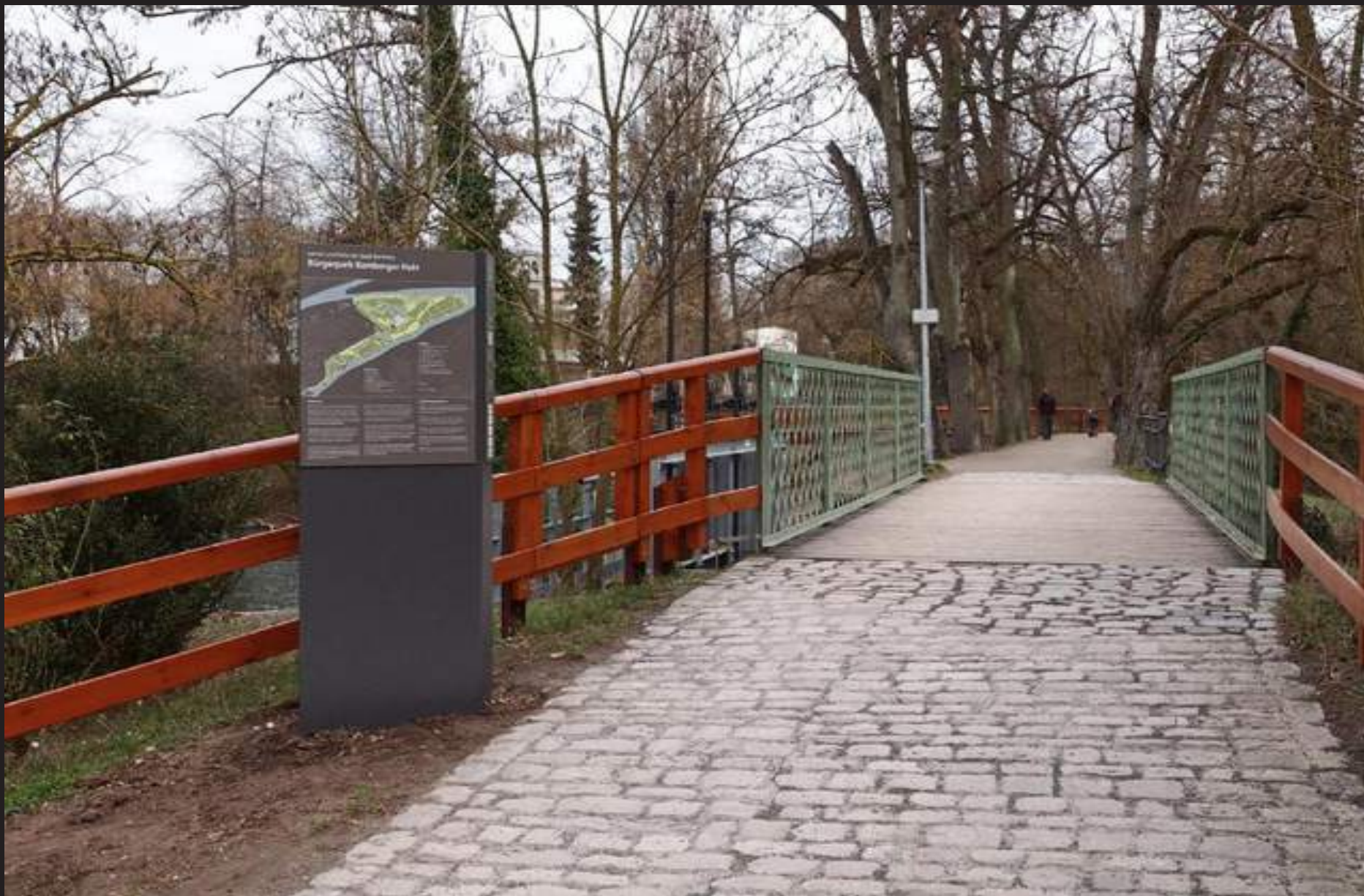
Neue Eingangsstele an der Stengelallee, 06.03.2019
