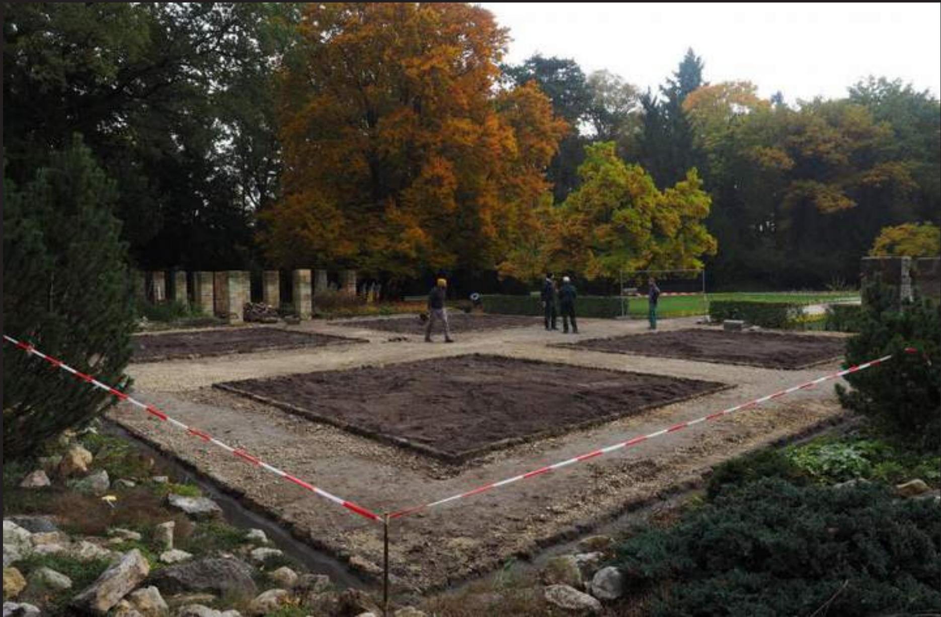
Fertigstellung der Quadratbeete vor dem Metznerhäuschen, 28.10.2016
