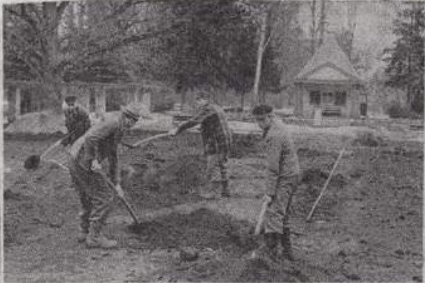
Im Botanischen Garten wird fleißig geschafft, um ihm ein völlig neues Bild zu geben. Die hochraubenden Hecken sind verschwunden, eine großzügige Anlage entsteht. Foto: FT-Bauer
