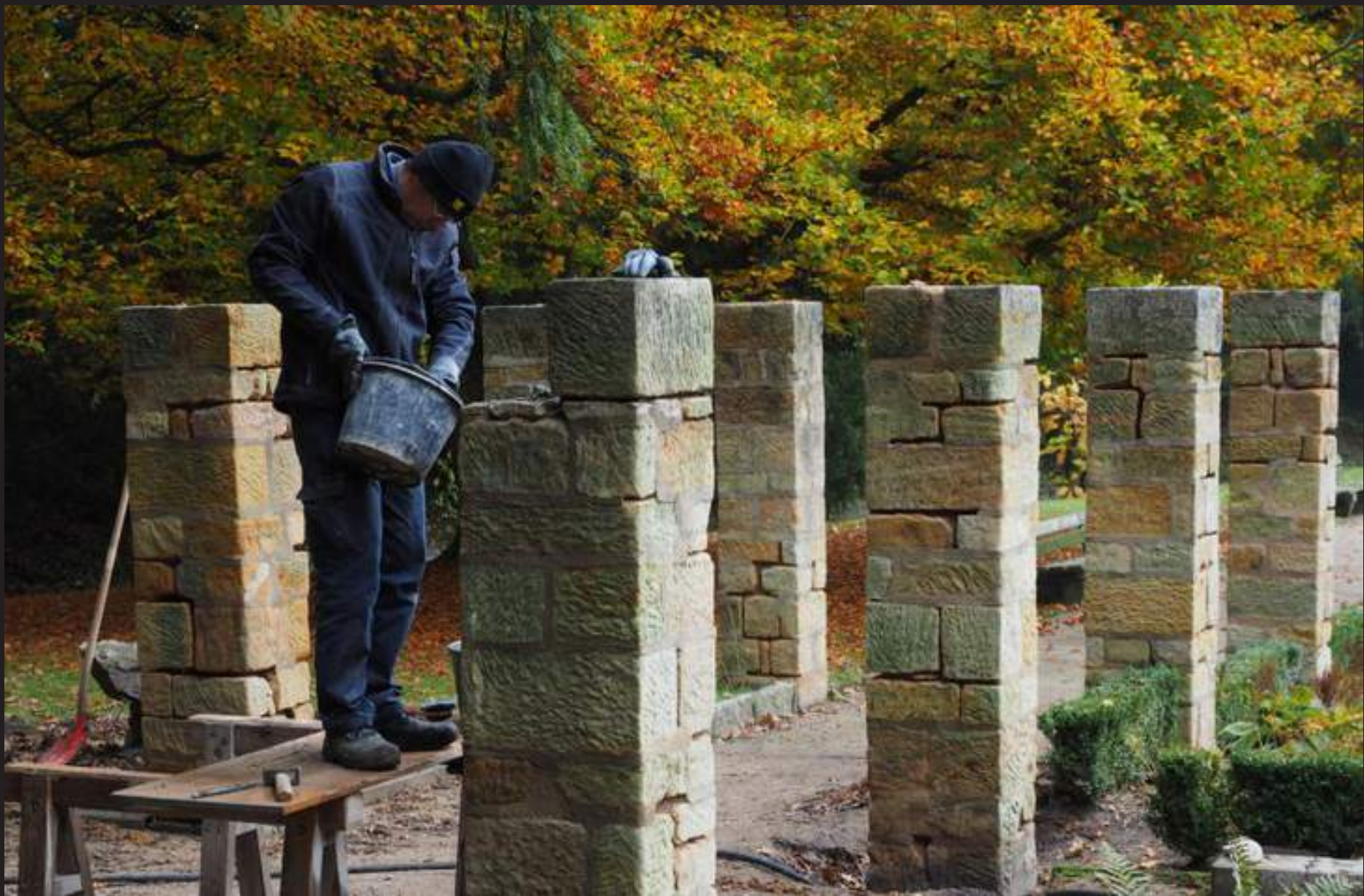
Sanierung der Pergolenpfeiler, 28.10.2016
